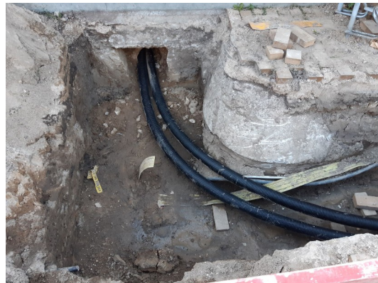
Erstatning med nye flexrør, her ved sokkel
