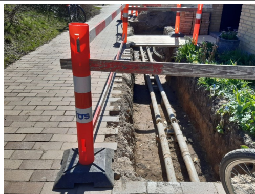
- og den forlænges, - mistanke om udbredt isolations skade
