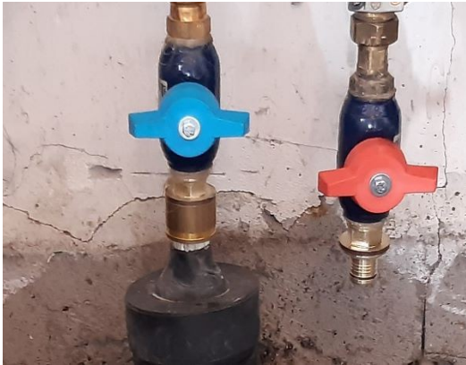
Afslutning af flexrør mod ventil, - princip.
