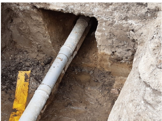
Lille stråle th. på rør ca. 30 cm fra sokkel
